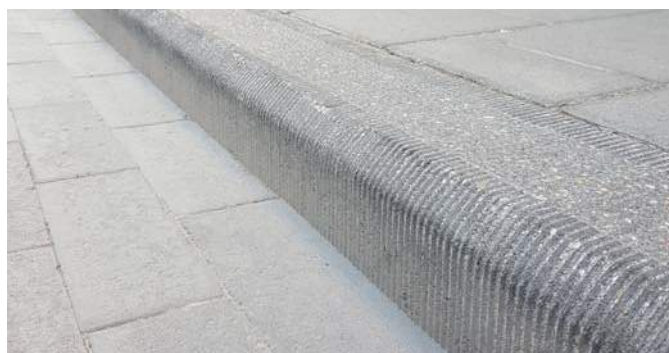
Bordure ciselée et bouchardée
