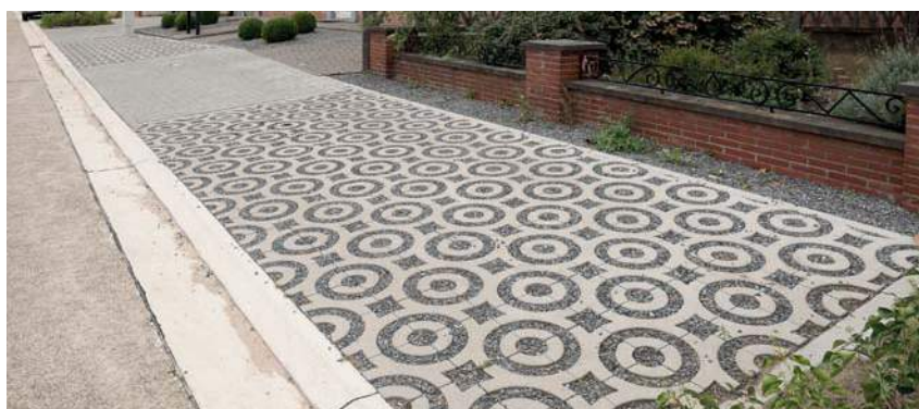
Bandes de parking dans la Kapelstraat à Laakdal
