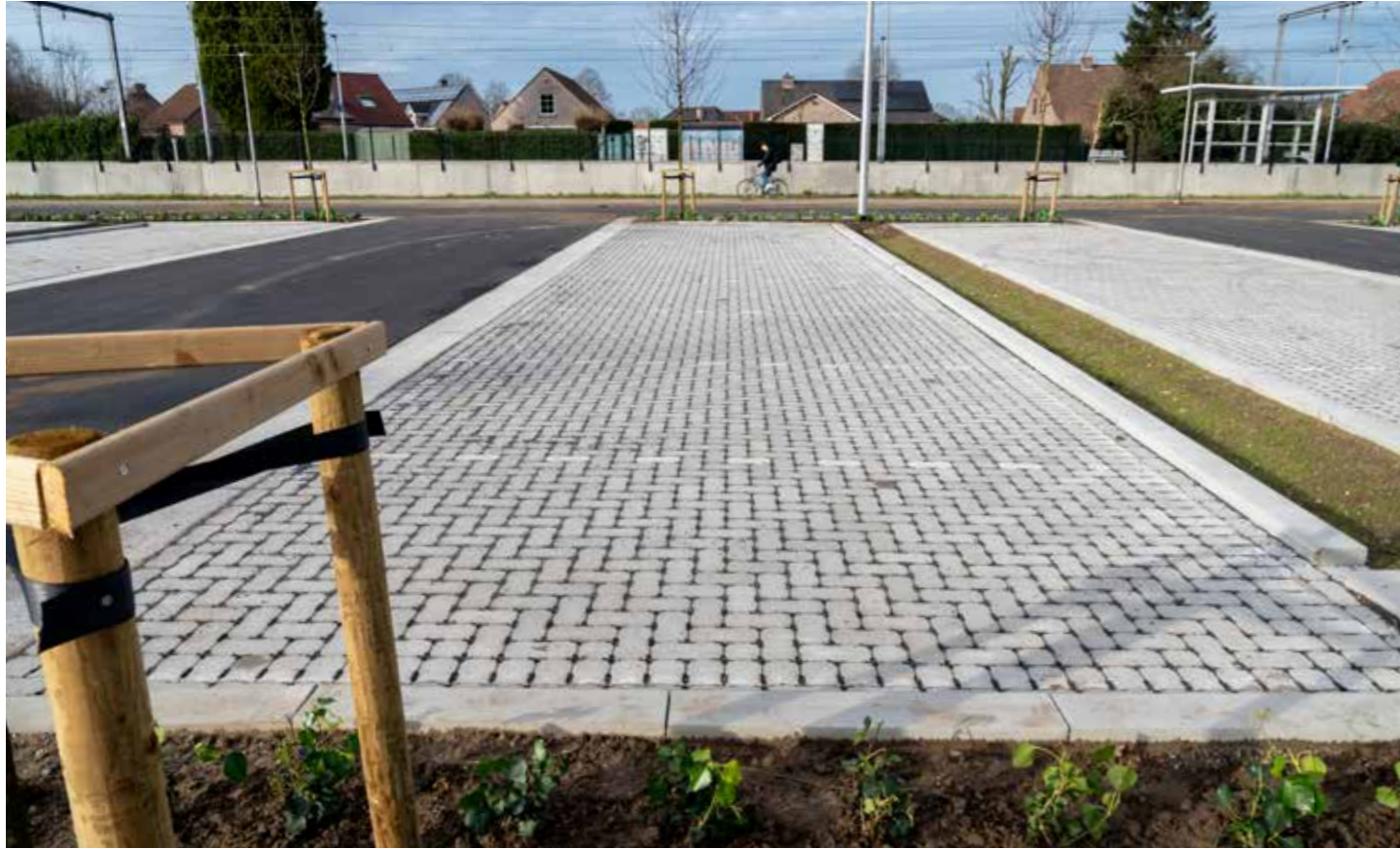
Kiewit - Point Hoppin - Halter en béton géopolymère - Éviter le ruissellement
