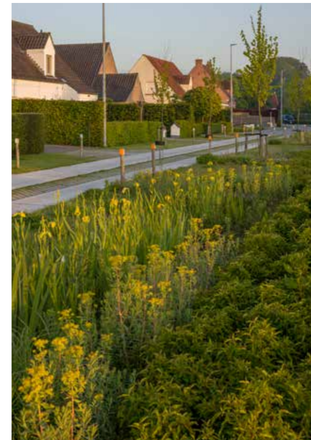
Rues-jardin Oostkamp - Voie publique - Helix - Éviter le ruissellement
