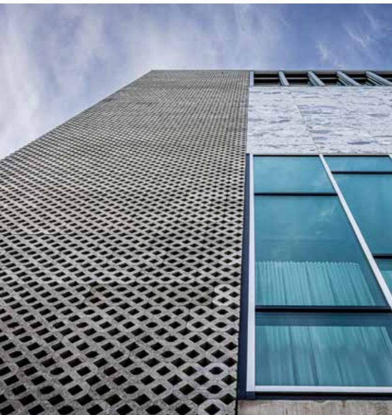
Borgerhout - Laboratoire hydraulique - Helix - Utilisation verticale
