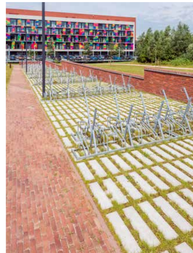
Hôpital Oost-Limburg - Stationnement vélos - Grasslines Big - Éviter le ruissellement
