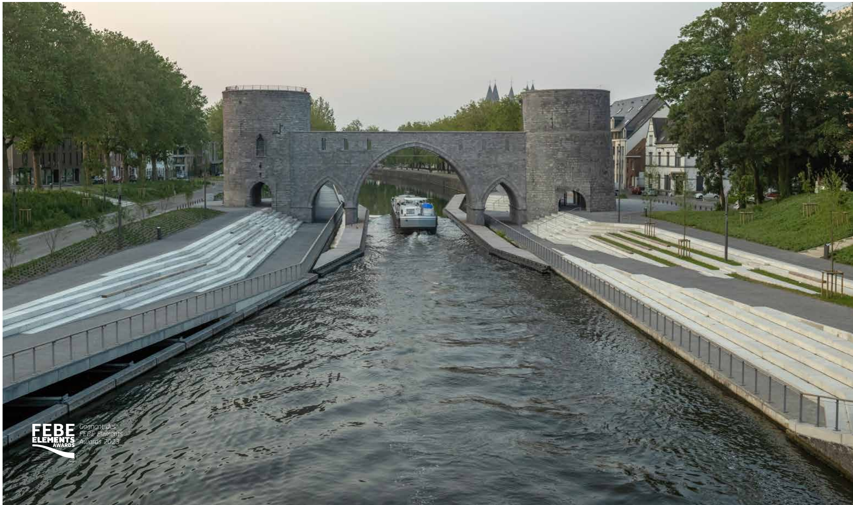
Tournai - Protection des berges - tribunes - projet CustomConcrete sur mesure - Gagnant des FEBE Elements Award Precast in Landscape 2023
