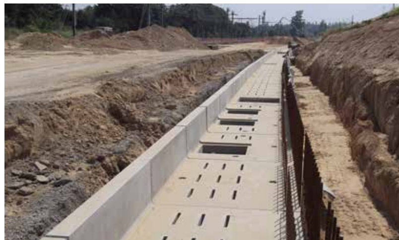
Chemin de fer - Caissons - Tamponnage
