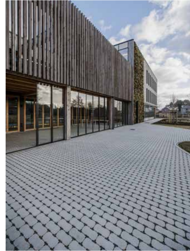
Westerlo - Kamp C - Abords d'entreprise - Halter béton géopolymère - Éviter le ruissellement
