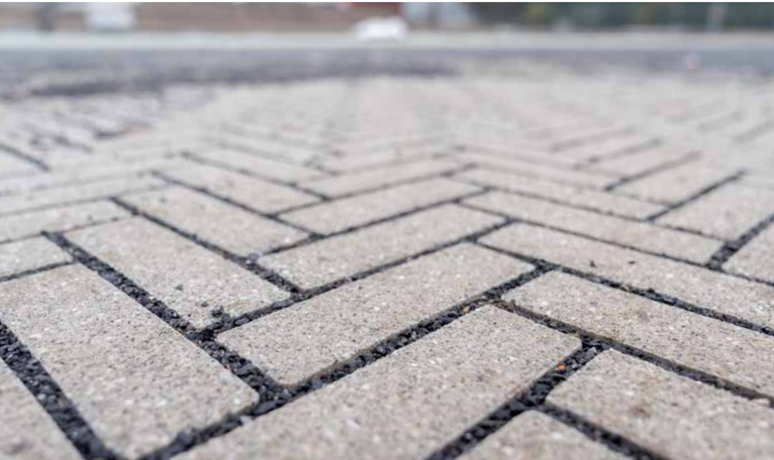
Lille - Sportoase - Parking - Bowler en béton géopolymère - Couleur Silver Light lavé - Éviter le ruissellement
