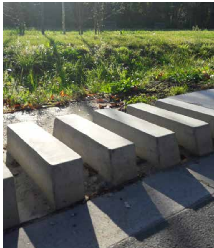
Mortsel - Voie publique - Bordure Streetline Aqua - Accotement d'infiltration
