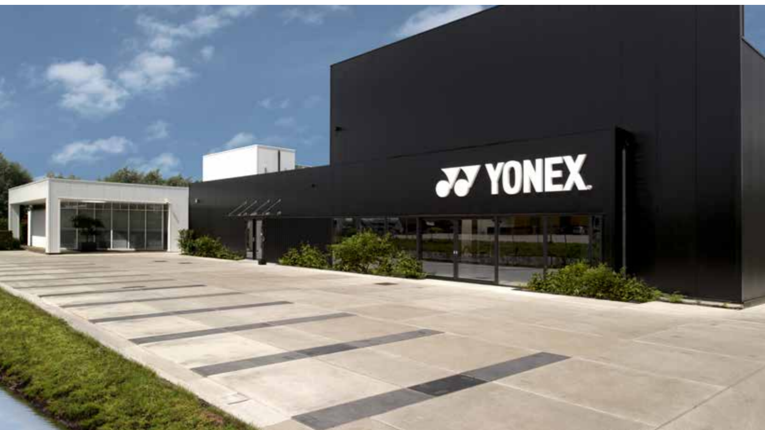
Aartselaar - Abords d'entreprise avec tamponnage HYDROPS © et dalles de sol Eurodal
