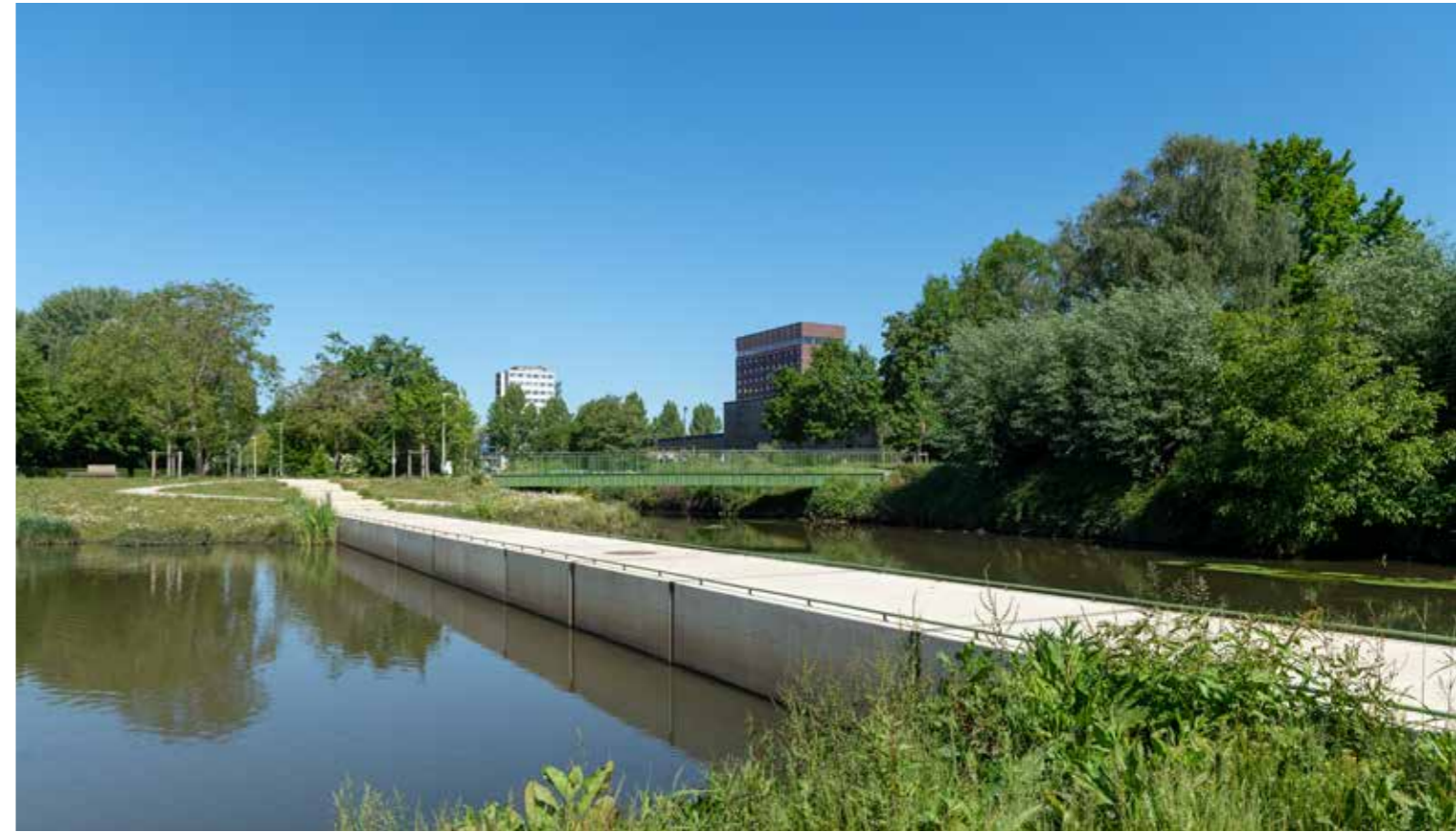
Hasselt - Zone d'étangs - Tamponnage
