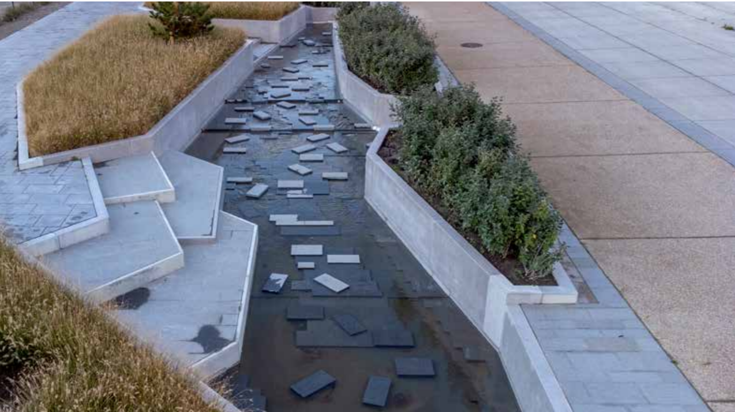
Ostende - City River - personnalisation CustomConcrete - tamponnage
