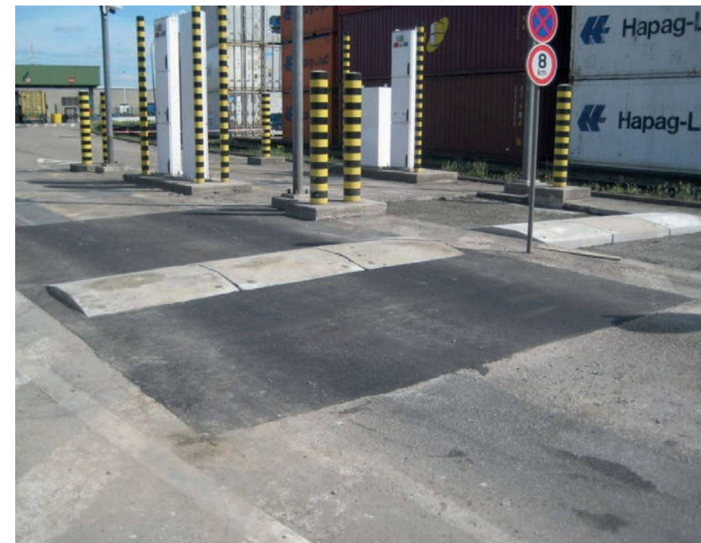
Middelhoge schampkanten scheiden het fietspad van de rijweg en verhogen het veiligheidsgevoel voor fietsers en voetgangers.
