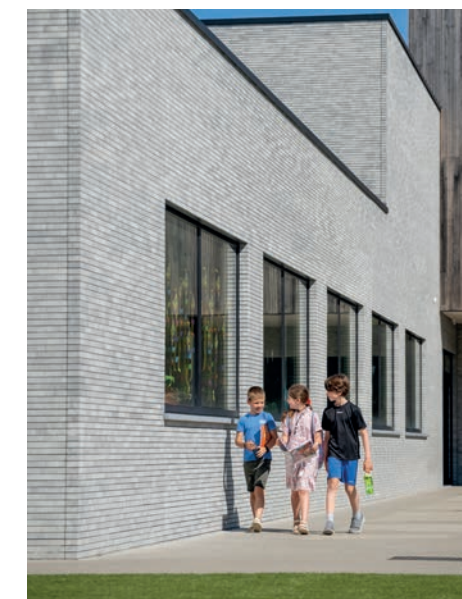
Zonhoven – Schoolgebouw De Startbaan – Panorama gevelstenen Cloud White
