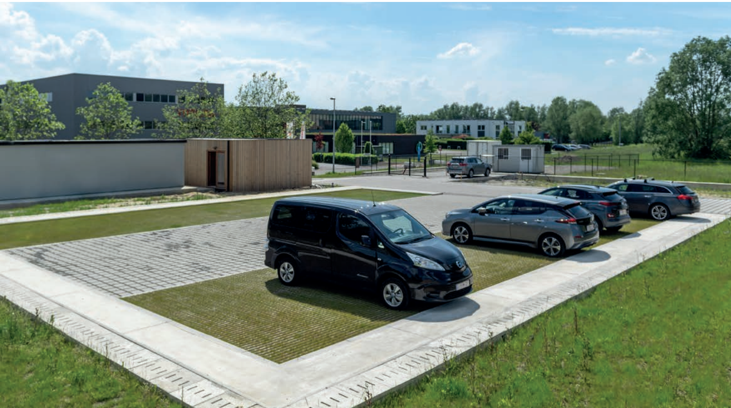
Asse -Bedrijfsterrein - Combinatieconcept - Greppels en deksel - Greenstone - Grasslines Small - Belastingsklasse BC6 en BC5
