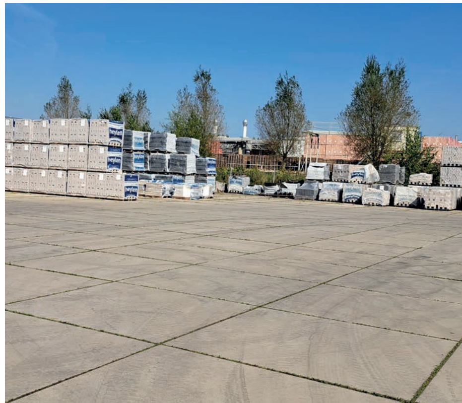
Rumst - Opslagplaats bedrijfsterrein - Eurodal Industrial
