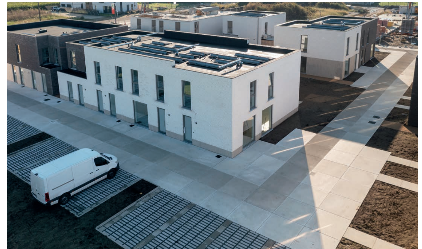
Wiekevorst – Nieuwbouwwoningen – B-rain Connect – straat met collectief regenwaterbeheer
