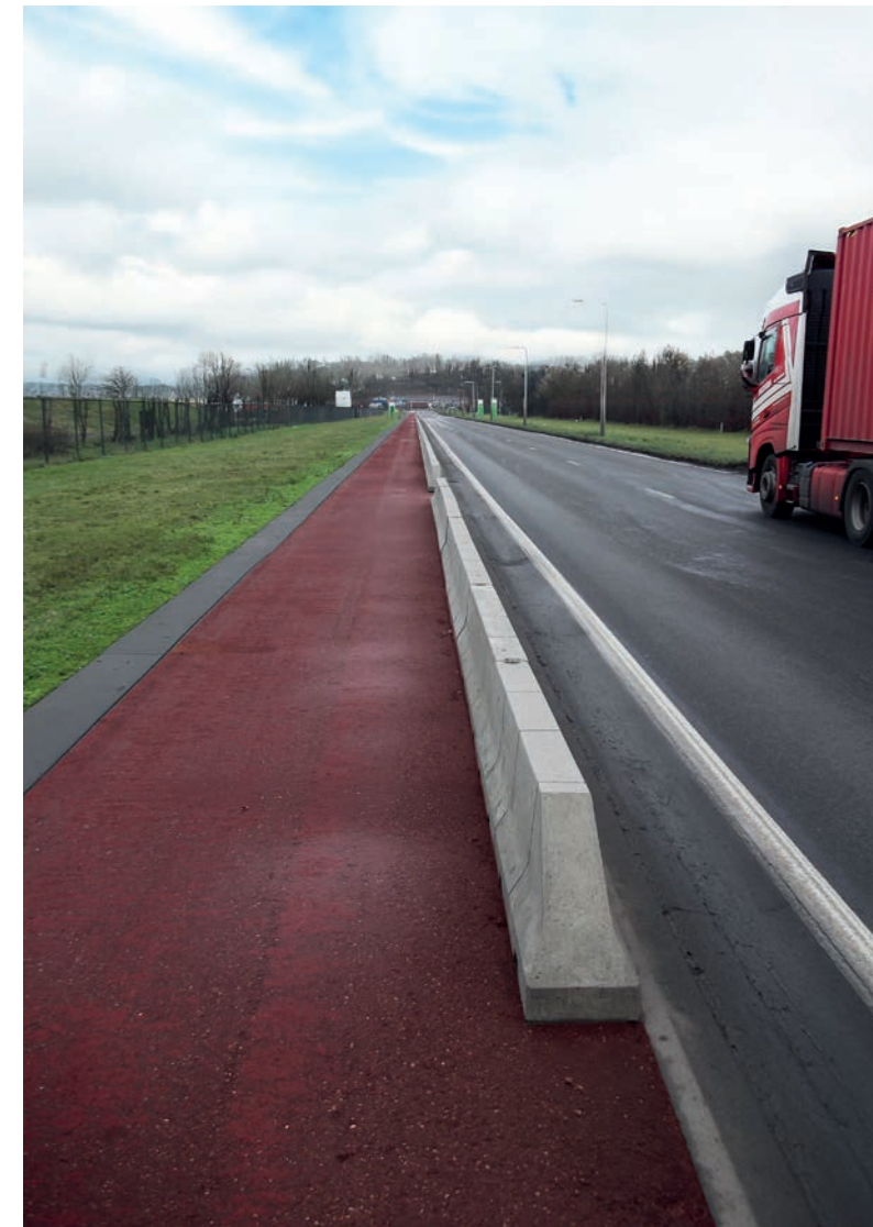
Middelhoge schampkanten scheiden het fietspad van de rijweg en verhogen het veiligheidsgevoel voor fietsers en voetgangers.
