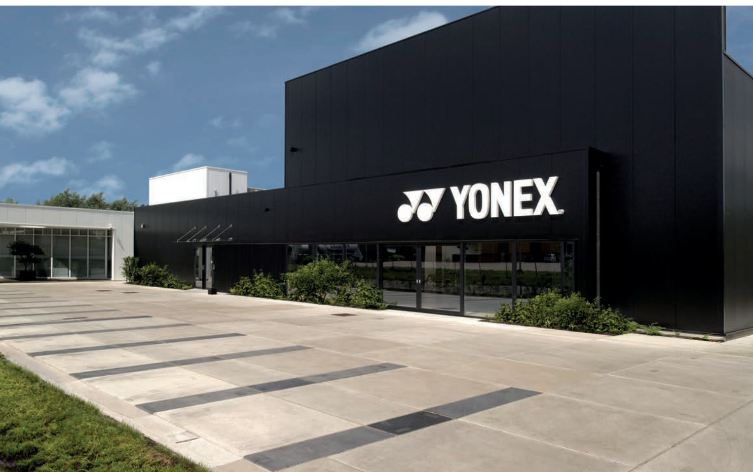
Aartselaar - Bedrijfsterrein met HYDROPS © waterbuffering en Eurodal vloerplaten
