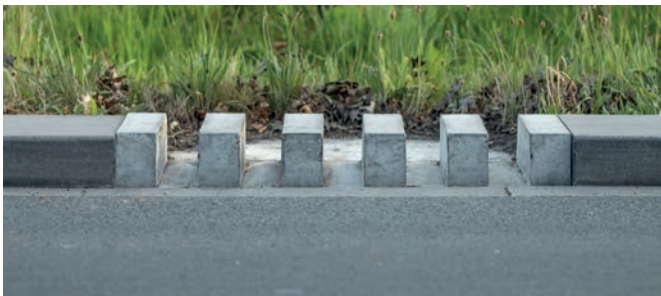
Mortsel - Afwatering van rijweg naar groene berm - Streetline Aqua Boordsteen
