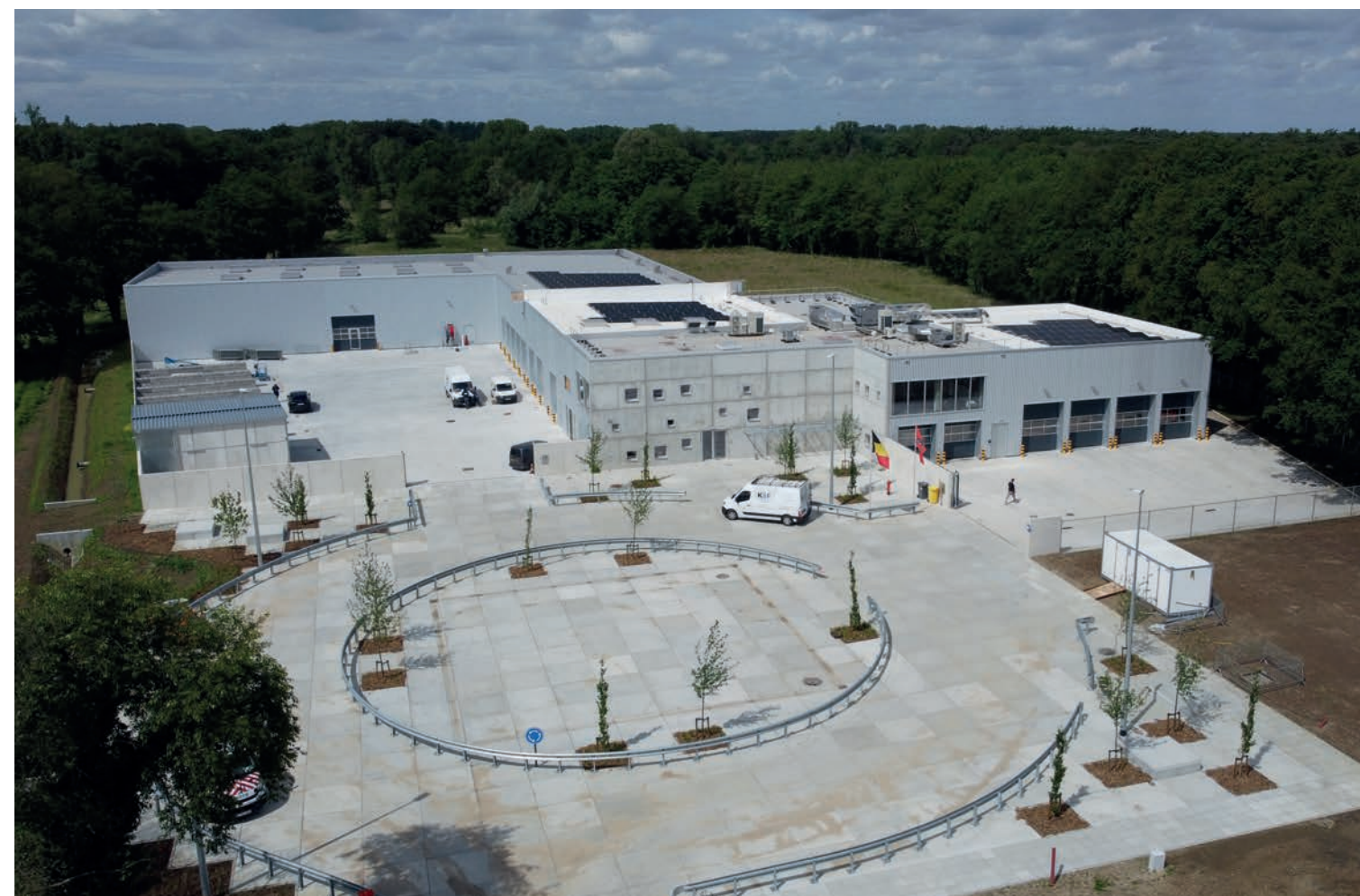
Brandweerkazerne Herenthout – Oprijlaan en plein – Eurodal Premium – Zaagwerk op maat
