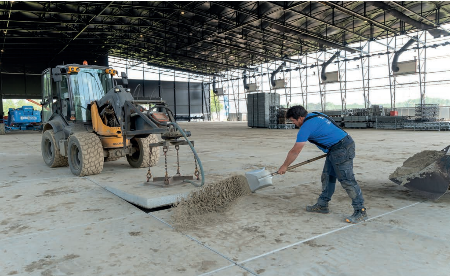
Rock Werchter - The Barn et route de service en backstage - Eurodal Industrial - Réutilisation annuelle
