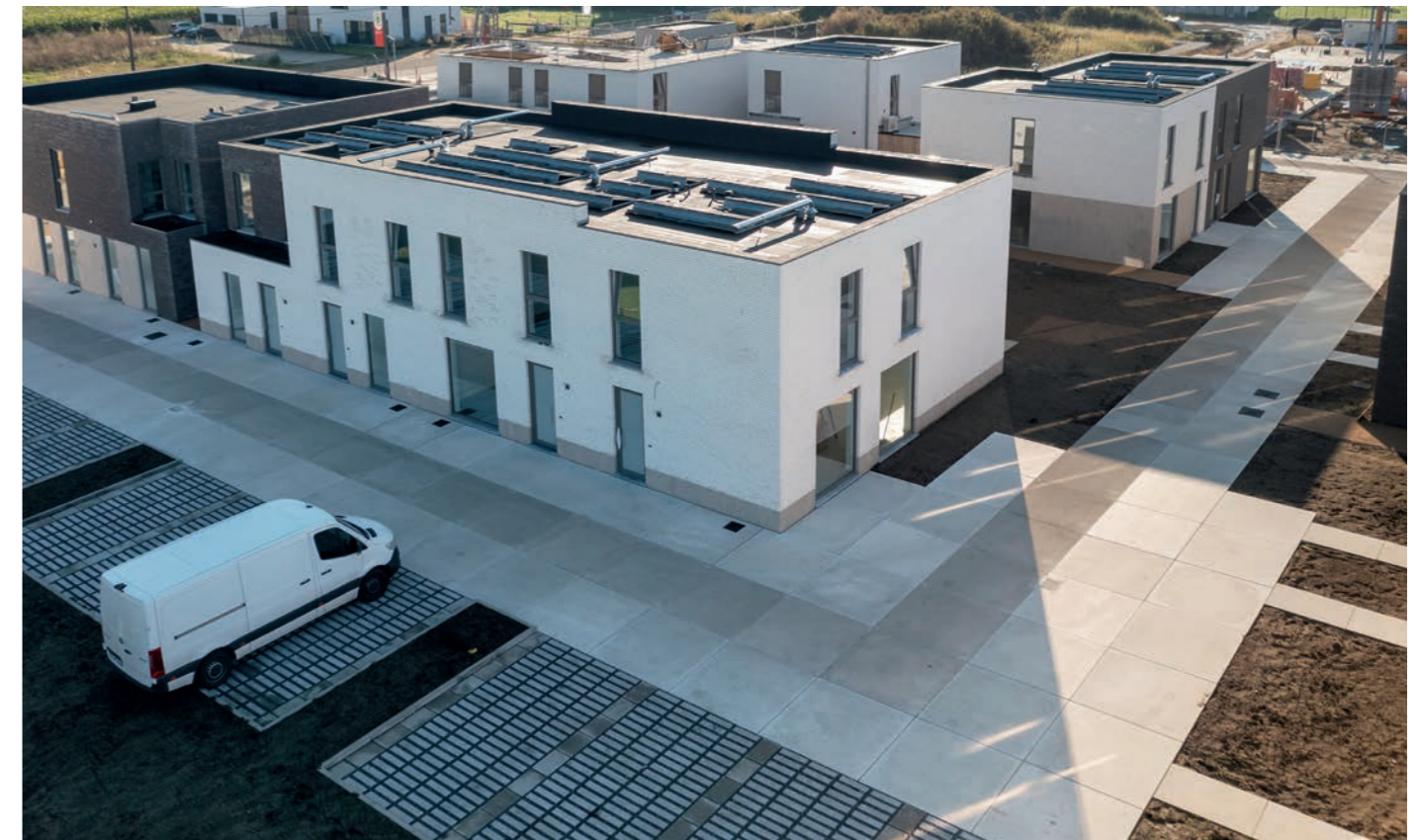
Wiekevorst - Maisons neuves - B-rain Connect - rue avec gestion collective des eaux de pluie
