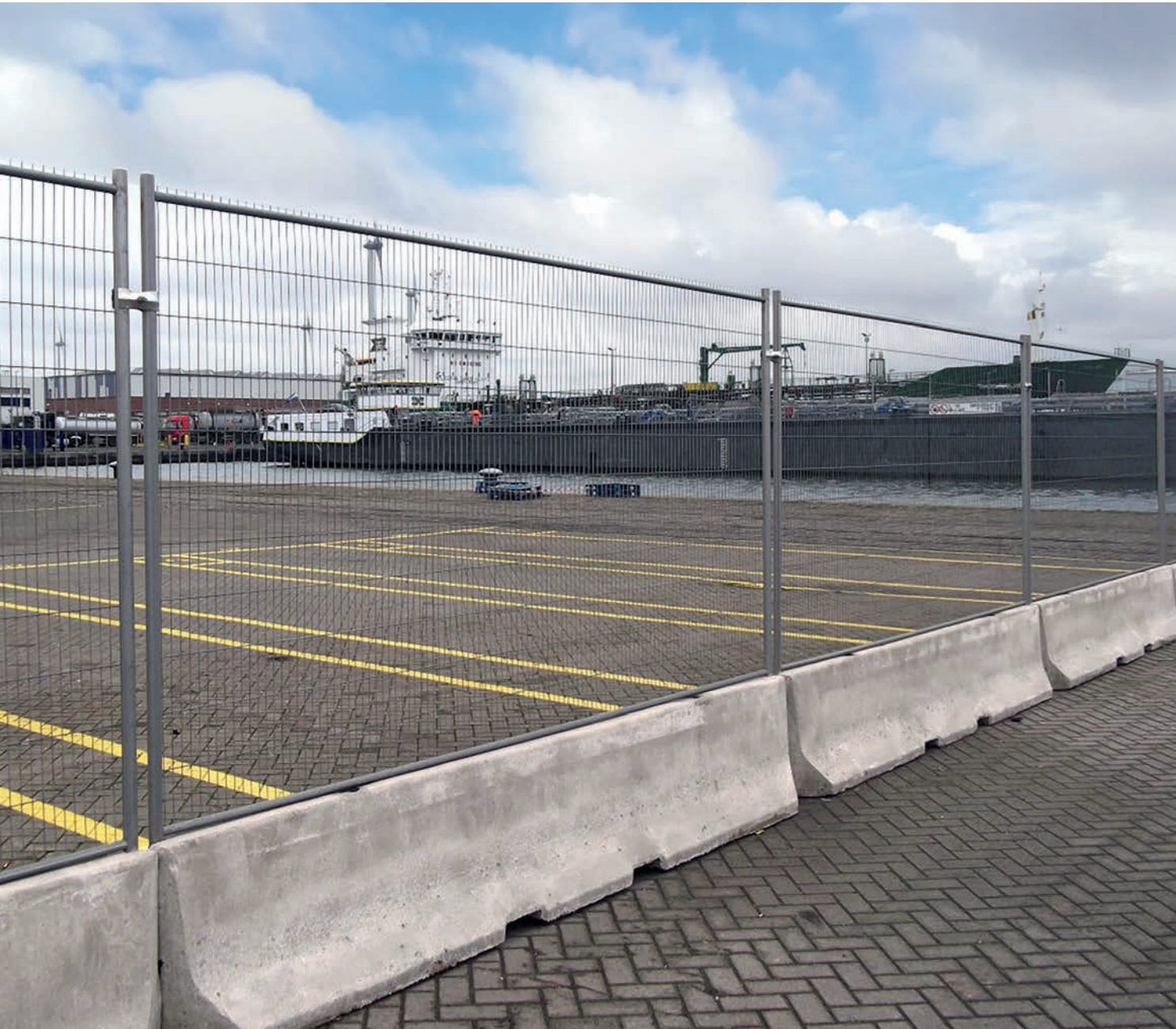
Les bordures chasse-roues New Jersey avec clôtures prémontées empêchent toute intrusion sur le site.
