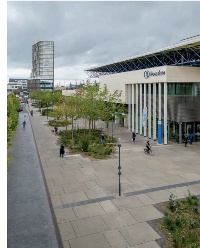
Place de la gare Roulers - Eurodal Premium - Projet de verdissement avec désasphaltage partiel et réutilisation des dalles de sol retirées
