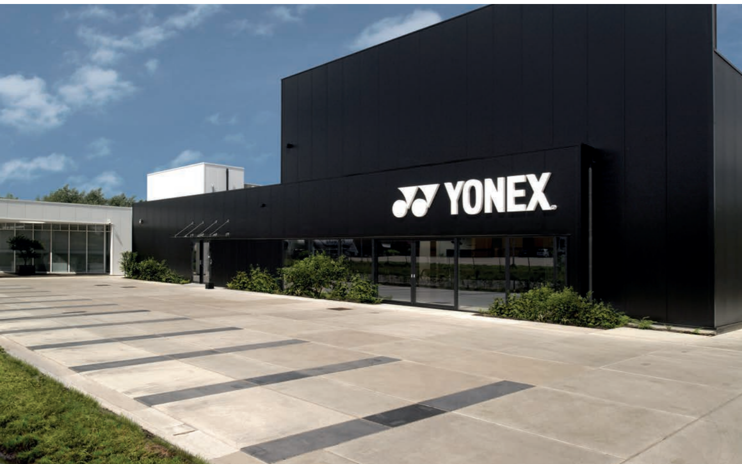
Aartselaar - Site industriel doté du système de stockage d'eau HYDROPS® et des dalles de sol Eurodal
