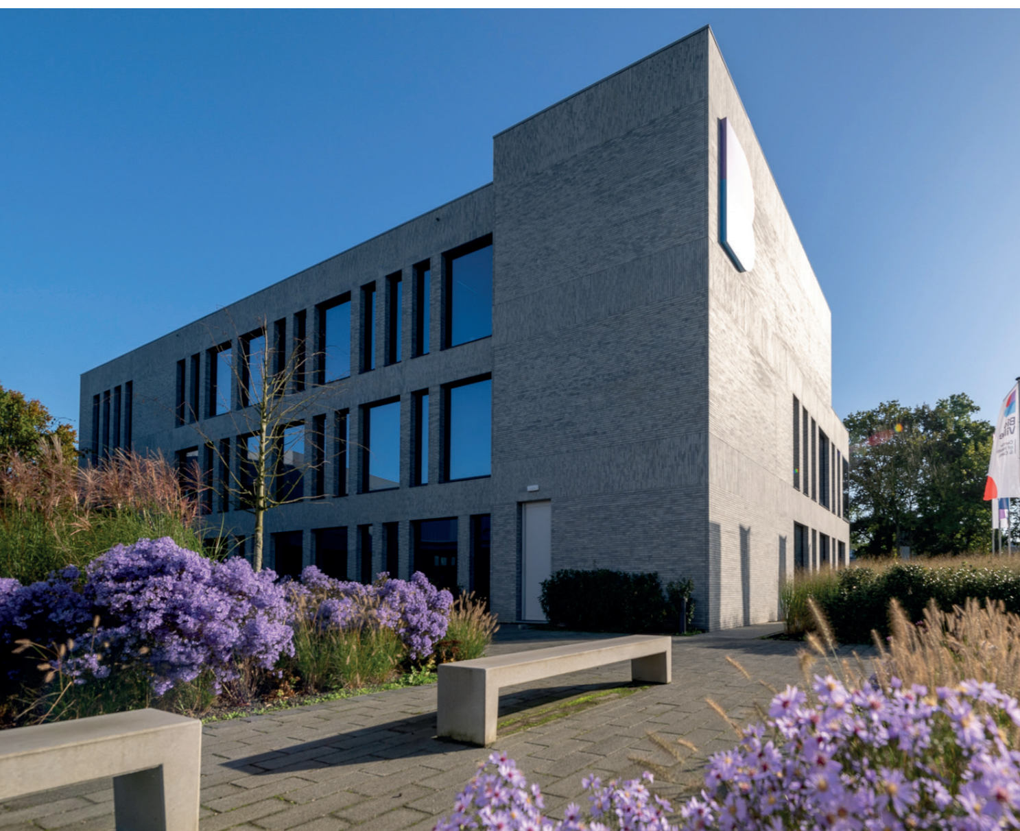
Diepenbeek – Immeuble de bureaux BioVille – Briques et plaquettes de parement Panorama Cloud White
