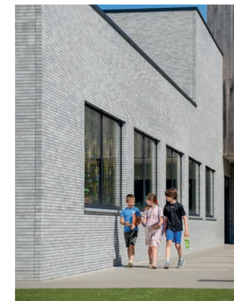
Zonhoven – École primaire De St@rtbaan – Briques de parement Panorama Cloud White
