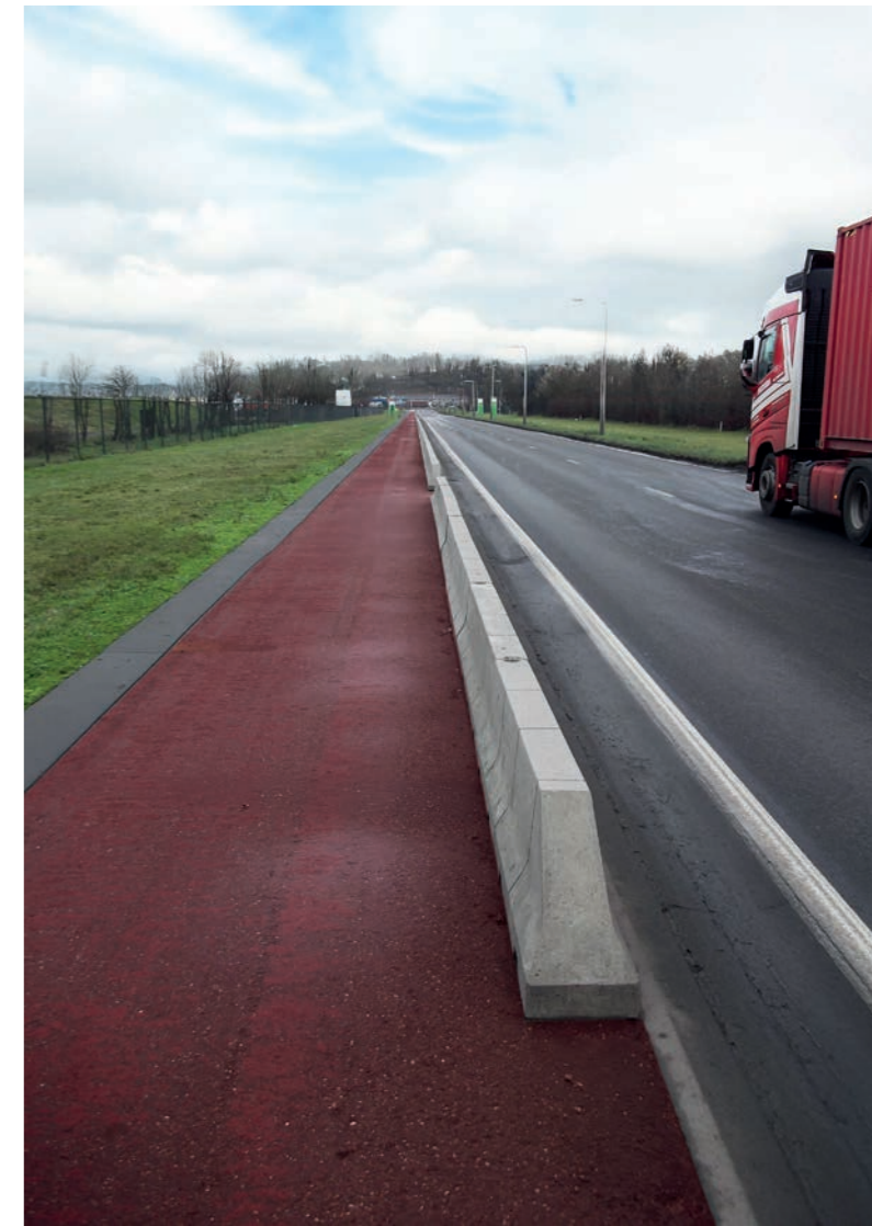
Les bordures chasse-roues moyennes séparent la piste cyclable de la chaussée et renforcent le sentiment de sécurité pour les cyclistes et les piétons.
