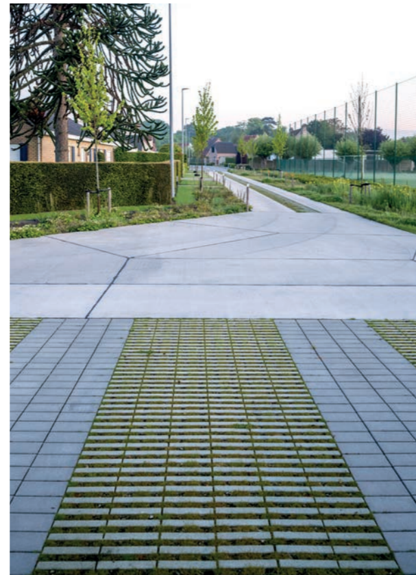
Oostkamp - Allée avec bandes carrossables - Concept de combinaison Grasslines Small - Seamstone - Classe de charge BC5 et BC6
