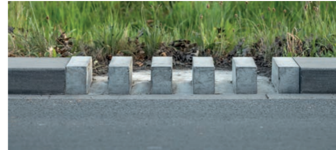
Mortsel - Écoulement de la chaussée vers l'accotement vert - Bordures Streeline Aqua
