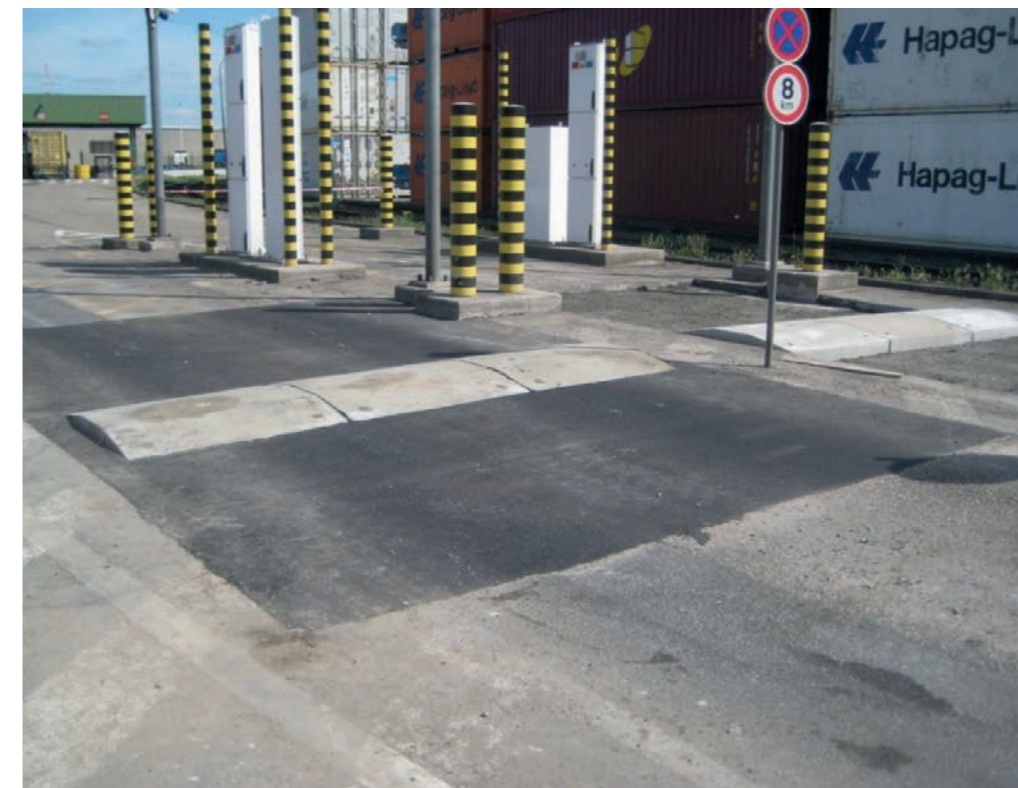
Les bordures chasse-roues moyennes séparent la piste cyclable de la chaussée et renforcent le sentiment de sécurité pour les cyclistes et les piétons.
